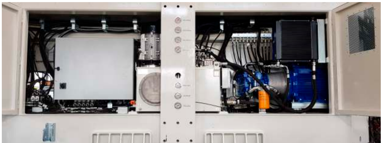
Particolare della centralina idraulica, quadro elettrico e pompa rotazione catena Close-up of the hydraulic unit, the power control board, and the chain rotation pump.
